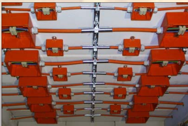
ROSE E 30-Gehäuse bestehen alle Anforderungen der Brandprüfung nach DIN 4102 Teil 12
