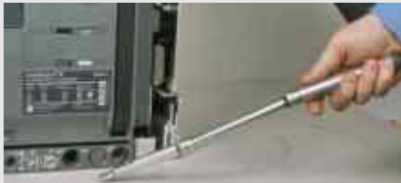
Fig. 1.10: Racking Handle use Рис. 1.10: Сборка рукоятки Fot. 1.10: Rozłożenie korbry
