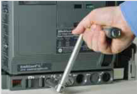
Fig. 1.12: Circuit Breaker in Maintenance Position Рис. 1.12: Выключатель в положении "Обслуживание" (выдвинут) Fot. 1.12: Wyłącznik w położeniu "Konserwacja" (Wysunięty)
