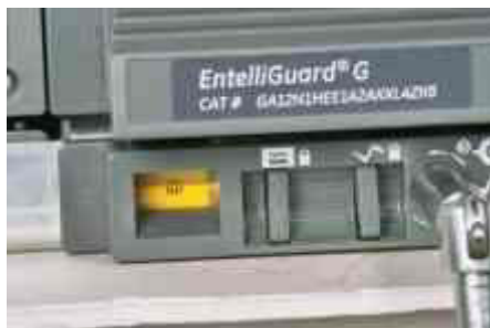
Racking drive in TEST position Привод вкатывания в положении ТЕСТ Napęd wsuwania w położeniu PRÓBA
