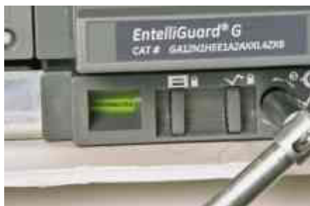
Racking drive in DISCONNECTED position Привод вкатывания в положении ОТКЛЮЧЕН Napęd wsuwania w położeniu ODŁĄCZONY
