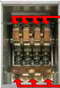
Fig 5.2: contact gap Рис. 5.2 Зазор между контактами Fot. 5.2: Szczelina między stykami
