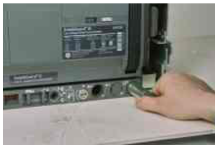
Racking Handle Storage Location Отсек для хранения рукоятки Schowek korby wsuwania
