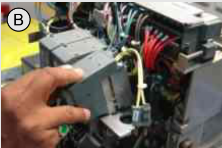
Рис. А: Разъем CCC Рис. В: Подключение катушки CCC Рис. С: Место подключения Рис. D: Катушка включения Рис. E: Клеммный блок вспомогательных цепей Рис. F: Удаление заглушки Рис. G: Дополнительная кнопка ручного включения
