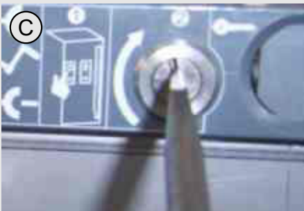
Fot. A: Wciśnięcie przycisku OFF w wyłączniku Fot. B: Obrócenie klucza przeciwnie do ruchu wskazówek zegara Fot. C: Odblokowanie
