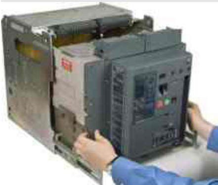
Fig. 1.12: Circuit Breaker in Maintenance Position Рис. 1.12: Выключатель в положении "Обслуживание" (выдвинут) Fot. 1.12: Wyłącznik w położeniu "Konserwacja" (Wysunięty)
