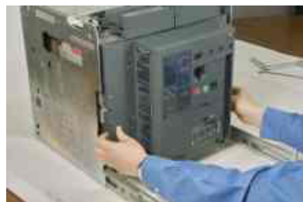
Pulling device from cassette for removal. Вынимание выключателя из кассеты с целью изъятия. Wyciągnięcie aparatu z podstawy w celu wyjęcia.
