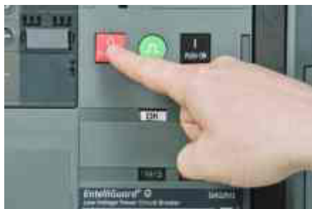
Turning device OFF Выключение устройства (OFF) Otwarcie aparatu (OFF)
