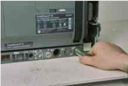
Fig. 1.9: Racking Handle Storage Location Рис. 1.9: Отсек для хранения рукоятки Fot. 1.9: Schowek korbry
