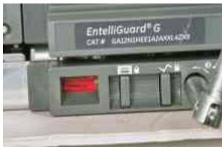
Racking drive in CONNECTED position Привод вкатывания в положении РАБОТА Napęd wsuwania w położeniu PRACA
