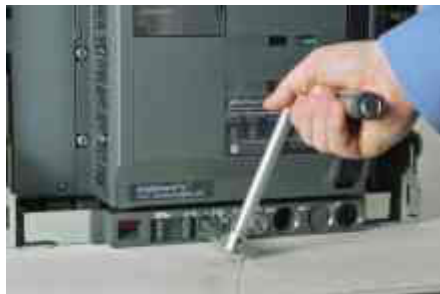
Racking Handle, engaged and in operation. Рукоятка, вставленная в привод, готовая к работе Korba wsuwania wprowadzona do napędu i gotowa do pracy.
