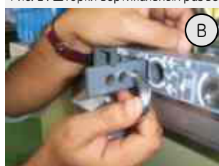
Рис. А : Блокировка защитных шторок C - Рычаг, блокирующий шторки, B - Открытие заслонки отверстия рукоятки Рис. B : Навешивание висячего замка на рычаг блокировки Рис. C : Шторки заблокированы Рис. D : Шторки горизонтальных разъемов Рис. E : Шторки вертикальных разъемов
