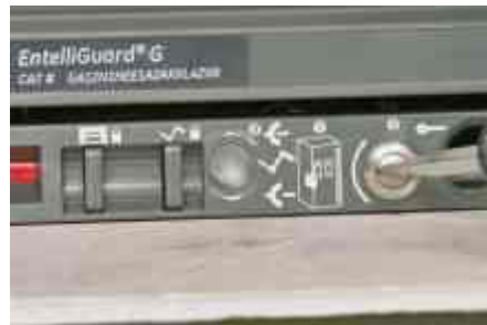
Racking Handle Shutter drive location Винт, передвигающий заслонку отверстия рукоятки Śruba przesuwająca przesłonę otworu korby
